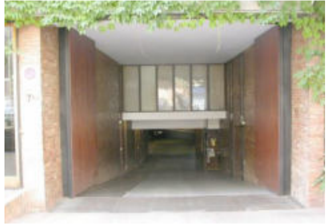
Traitement qualitatif des entrées au parking en sous-sol
