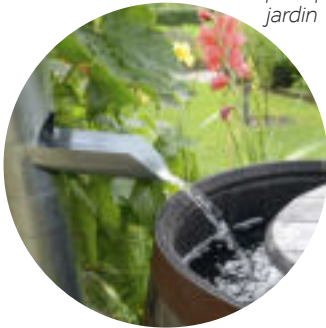
Récupération des eaux de pluie pour le jardin
