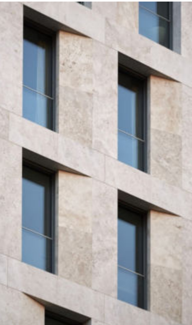
LOGEMENTS À MUNICH - MAX DUDLER
