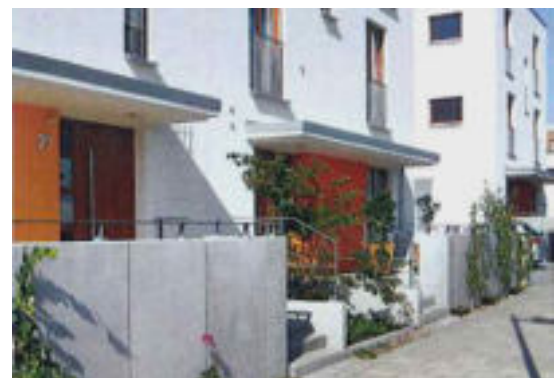
Des entrées aux logements clairement matérialisées et valorisées
