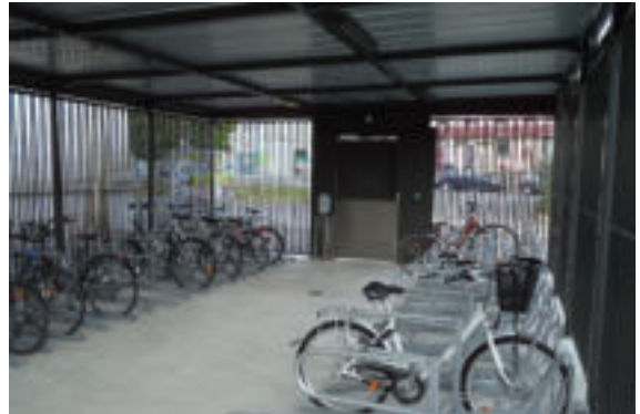
Local vélo intérieur éclairé naturellement et accessible de plain-pied
