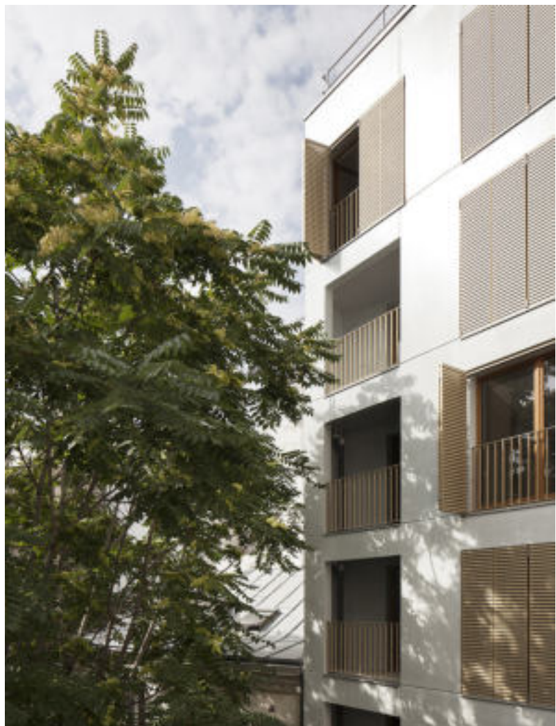
LOGEMENTS À SAINT-MAUR - AVENIER CORNEJO
