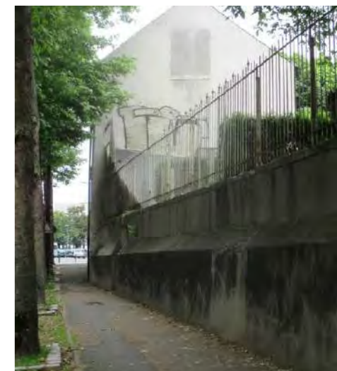
Mur sur rue du Pavillon Saint-Anne
