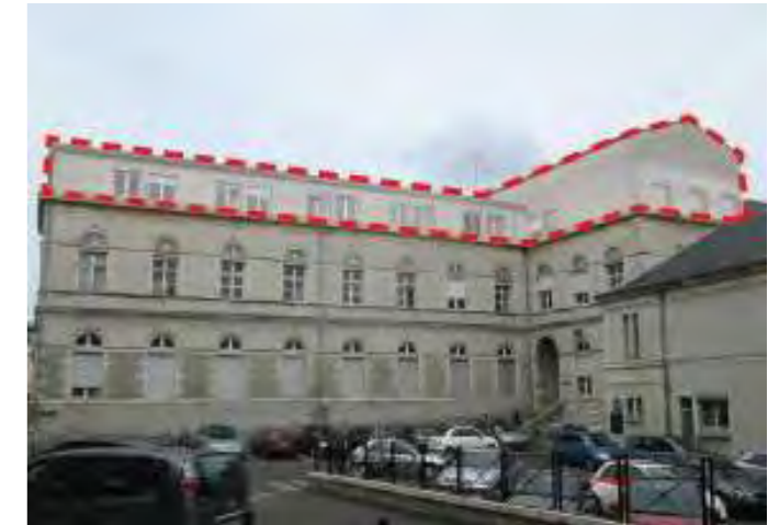
Constructions adossées au bâtiment d'origine
