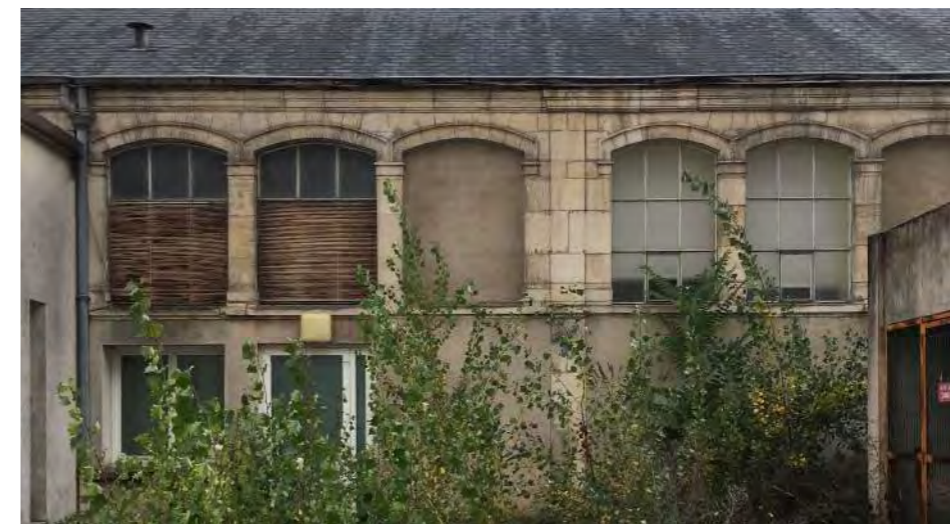
Façade Nord de la morgue, futur groupe scolaire.
