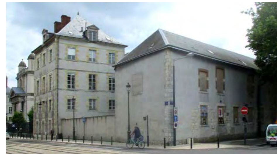
Jonction entre le pavillon Saint-Anne et l'hôpital général.
