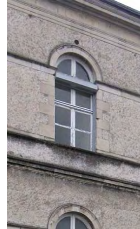
Façade arrière sud de l'Hôtel Dieu
