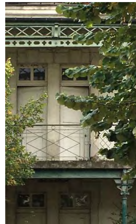
Balcons et coursives des logements
