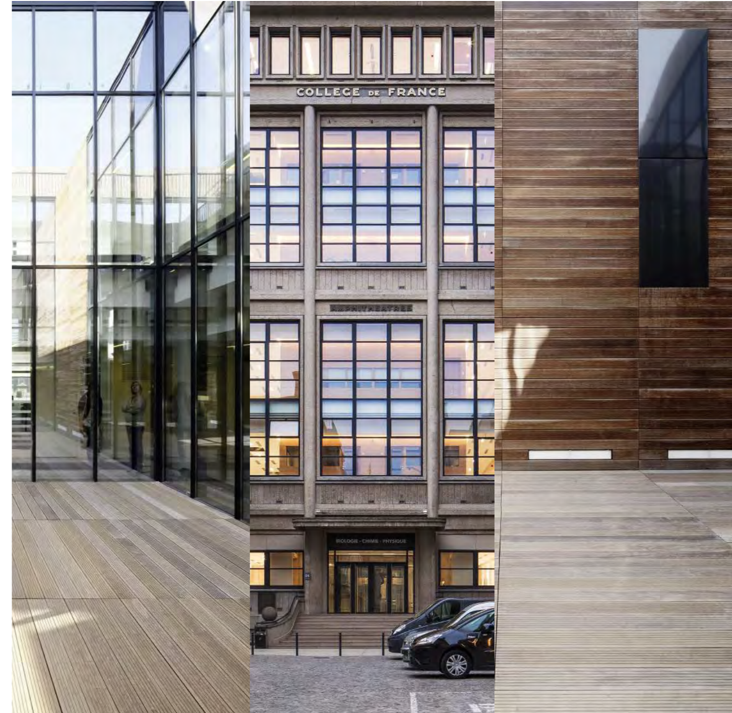
Mur rideau, intérieur d'îlot
