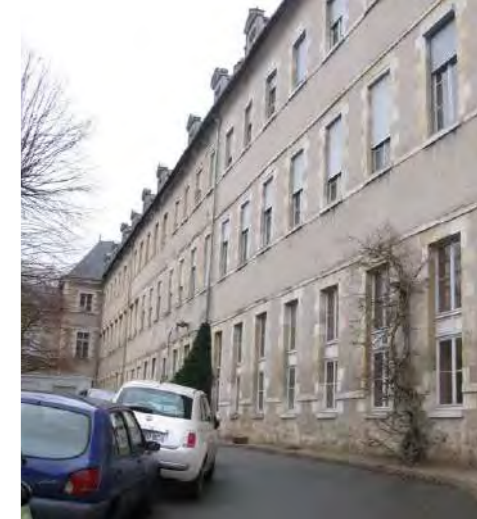
État Actuel de la façade Sud.
