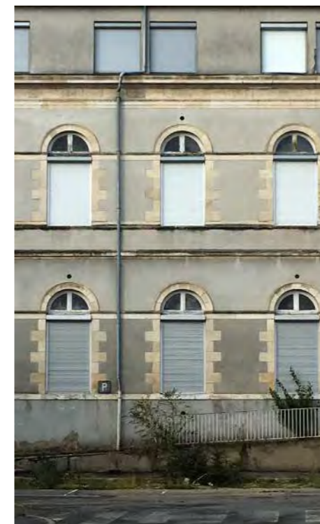
Façade Sud bâtiment A9
