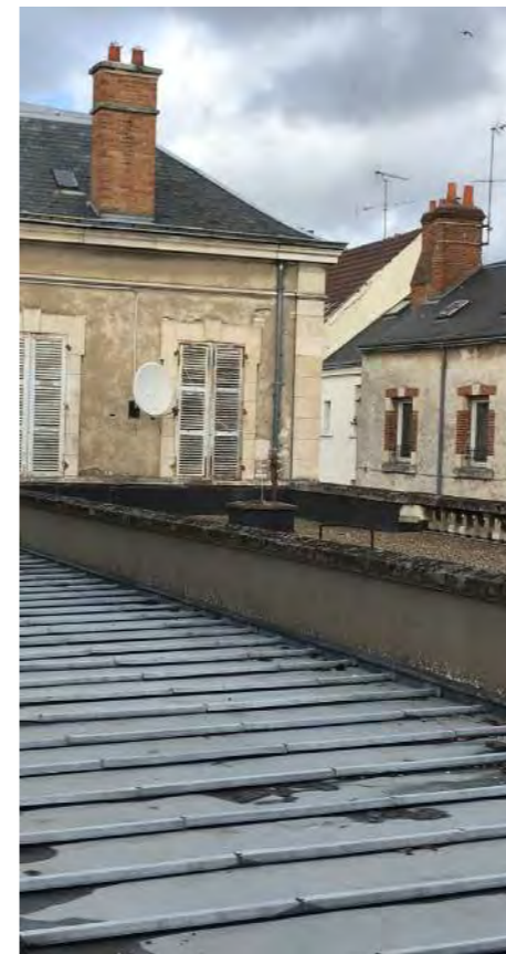
Vue depuis la coursive Sud de la Pension
