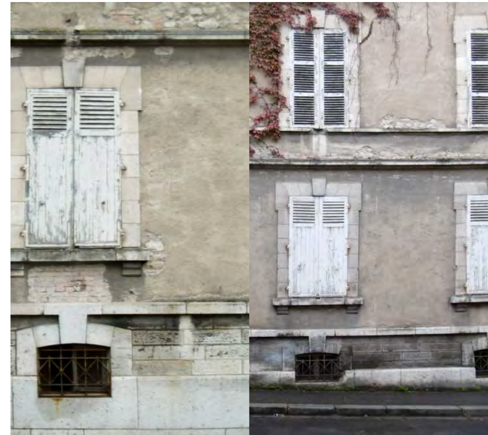
Fenêtres sur rue Croix-de-bois
