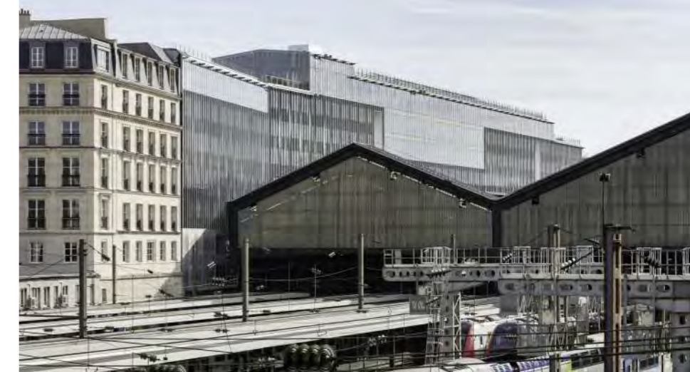
Réhabilitation et réinterprétation en façade
