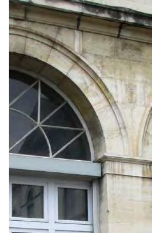
Cour d'entrée de l'Hôtel Dieu
