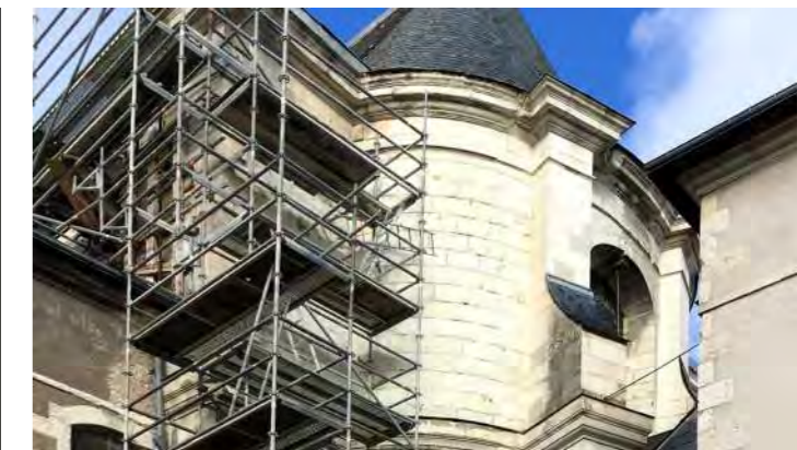
Proximité de la chapelle avec la réhabilitation
